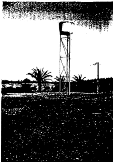
Un château d'eau de 7 m 3 en polyester
