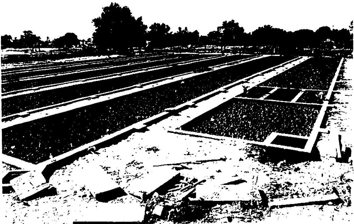
- Photo de la station de traitement des eaux à Rufisque
