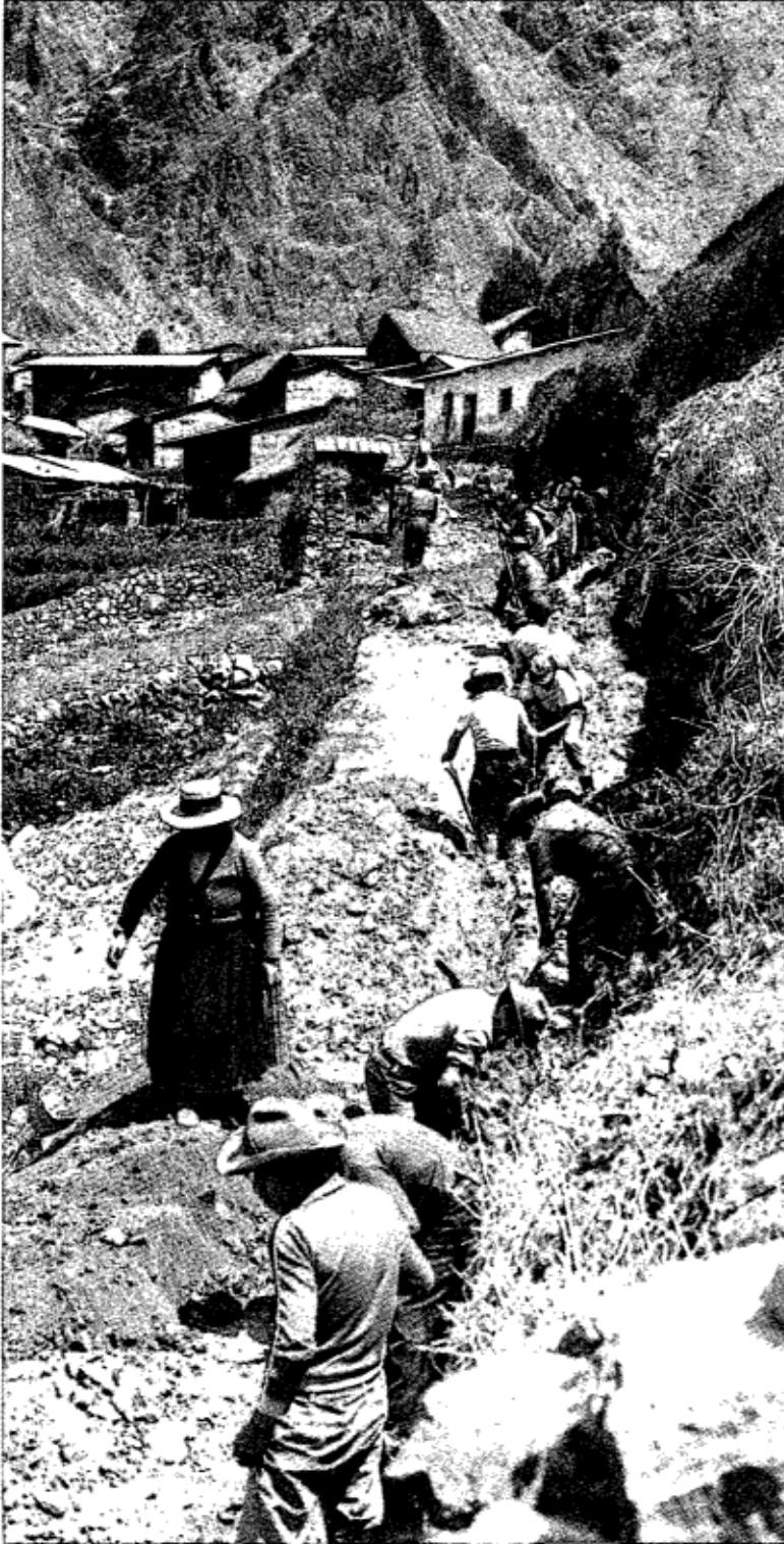
Excavación de zanja (Uramaza, Cajatambo, Lima).
