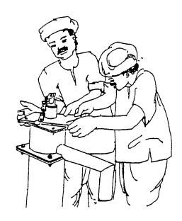
FIG:4:41 PUTTING MIDDLE FLANGE OVER WATER TANK
