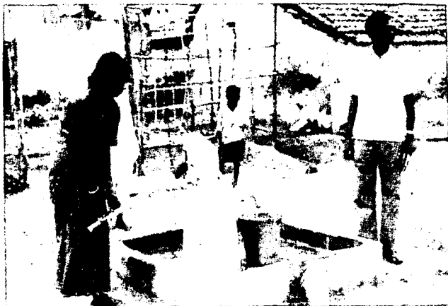
Este mango de bomba es muy bajo para una operación cómoda
