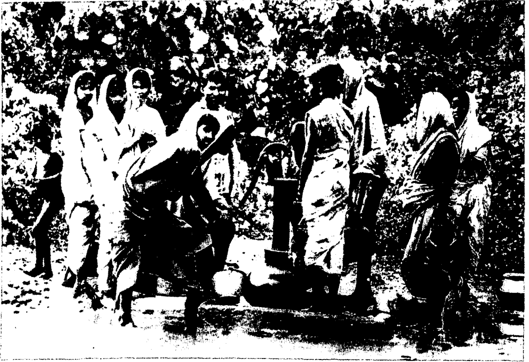
FIGURA 4-3 BOMBA DE MANO CON DRENAJE INADECUADO
