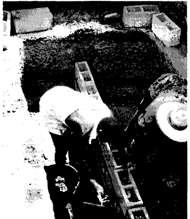
La construction d'une double fosse
