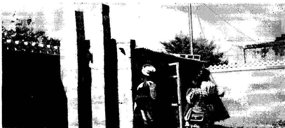
Latrines à double fosse ventilée.
