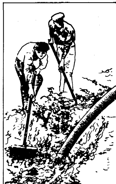
Opération de pompage des boues
