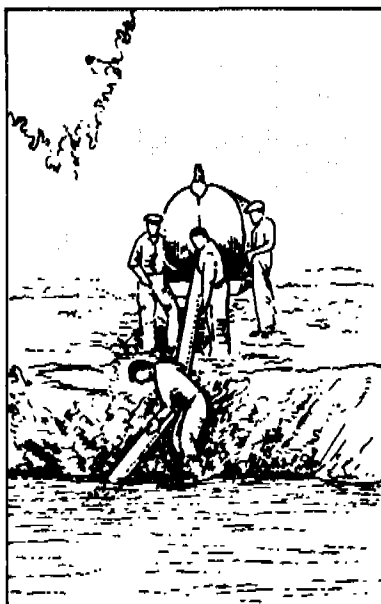
Mise en place de la pompe
