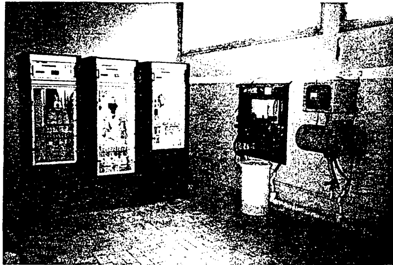
Fig. 11. Batterie d'analyseurs automatiques de qualité d'eau (Doc. SEIT)
