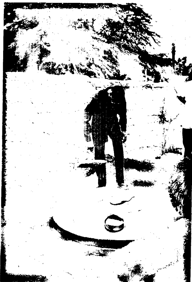
Figure 12: Latrine en construction avec couvercle lourd
