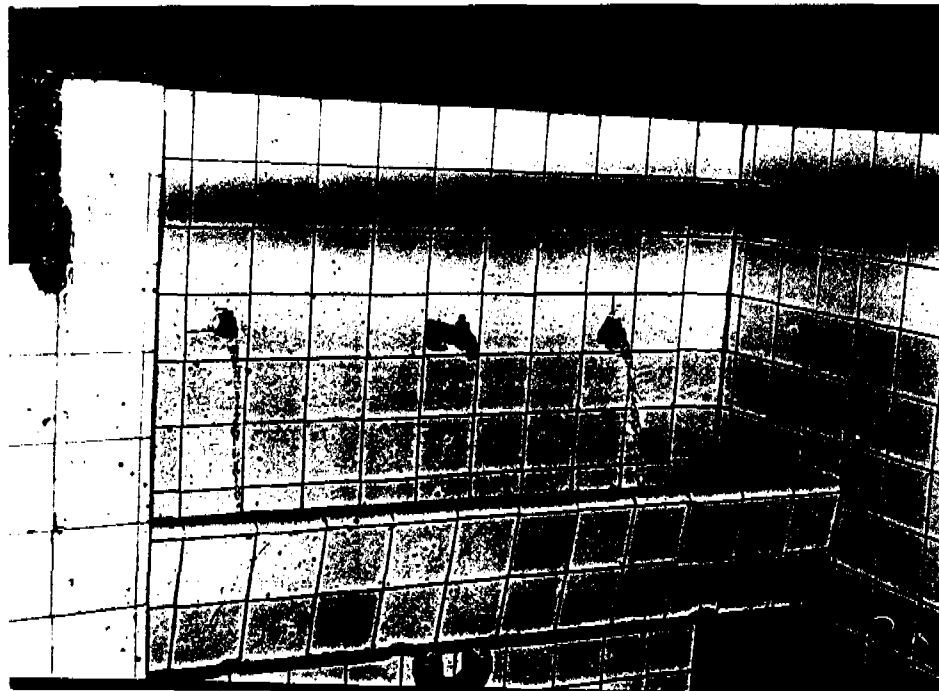
FOTO 9. Los bebederos de la escuela en mal estado
