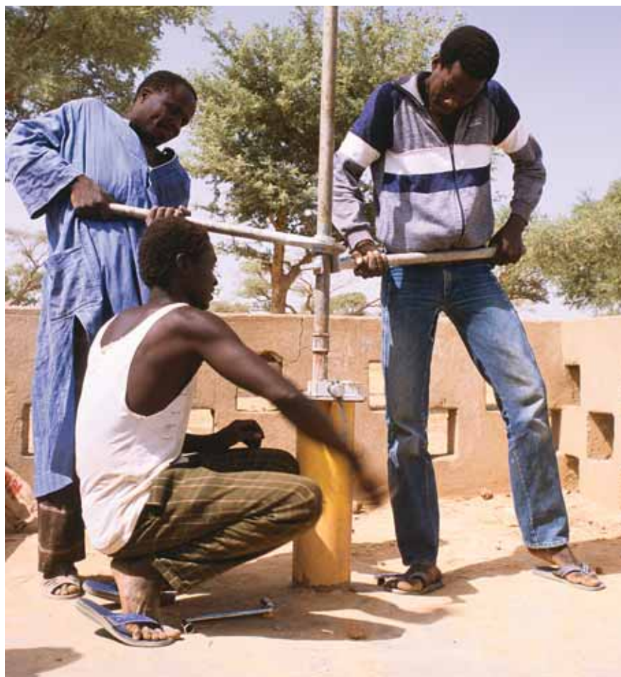
Técnica de perfuração manual de baixo custo
