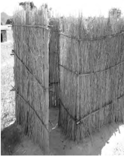
Latrine à fosse réalisée à partir de matériaux locaux.
