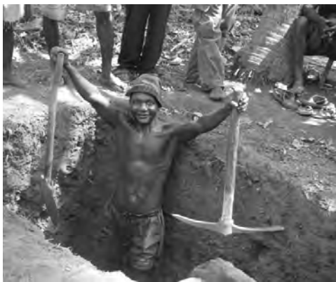
Un jeune homme commence à creuser une latrine pour sa maison à l'issue d'une séance de déclenchement.
