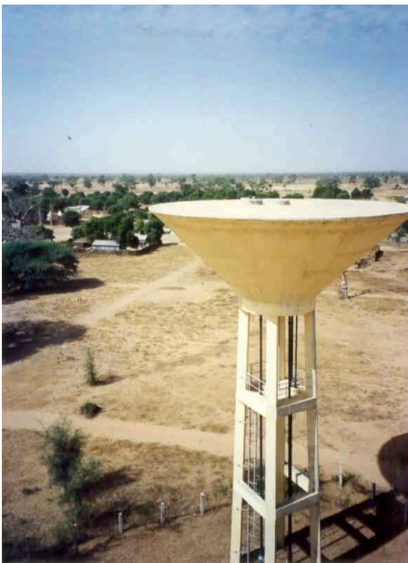
Château d'eau de Refane, Sénégal
