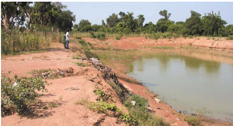
Les crevasses hors des zones d'habitation sont généralement des lieux de rejet anarchique des boues de vidange
